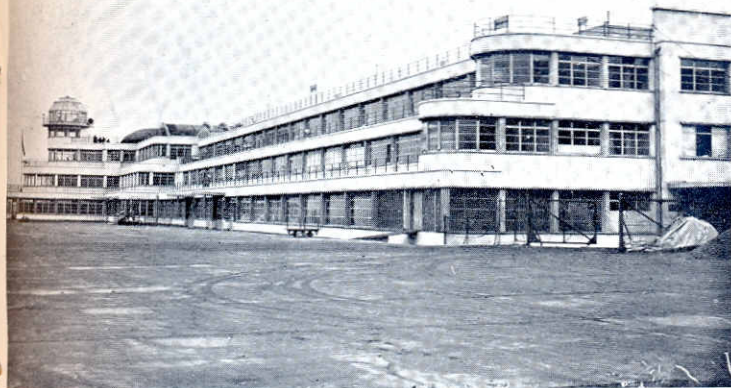
Interessante aspecto das novas instalações do aeroporto francês de Bourget
